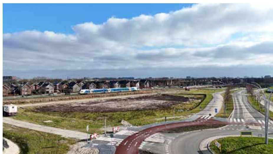
Op het terrein voor het toekomstige AZC in De Tippe zijn de voorbereidende werkzaamheden hervat
