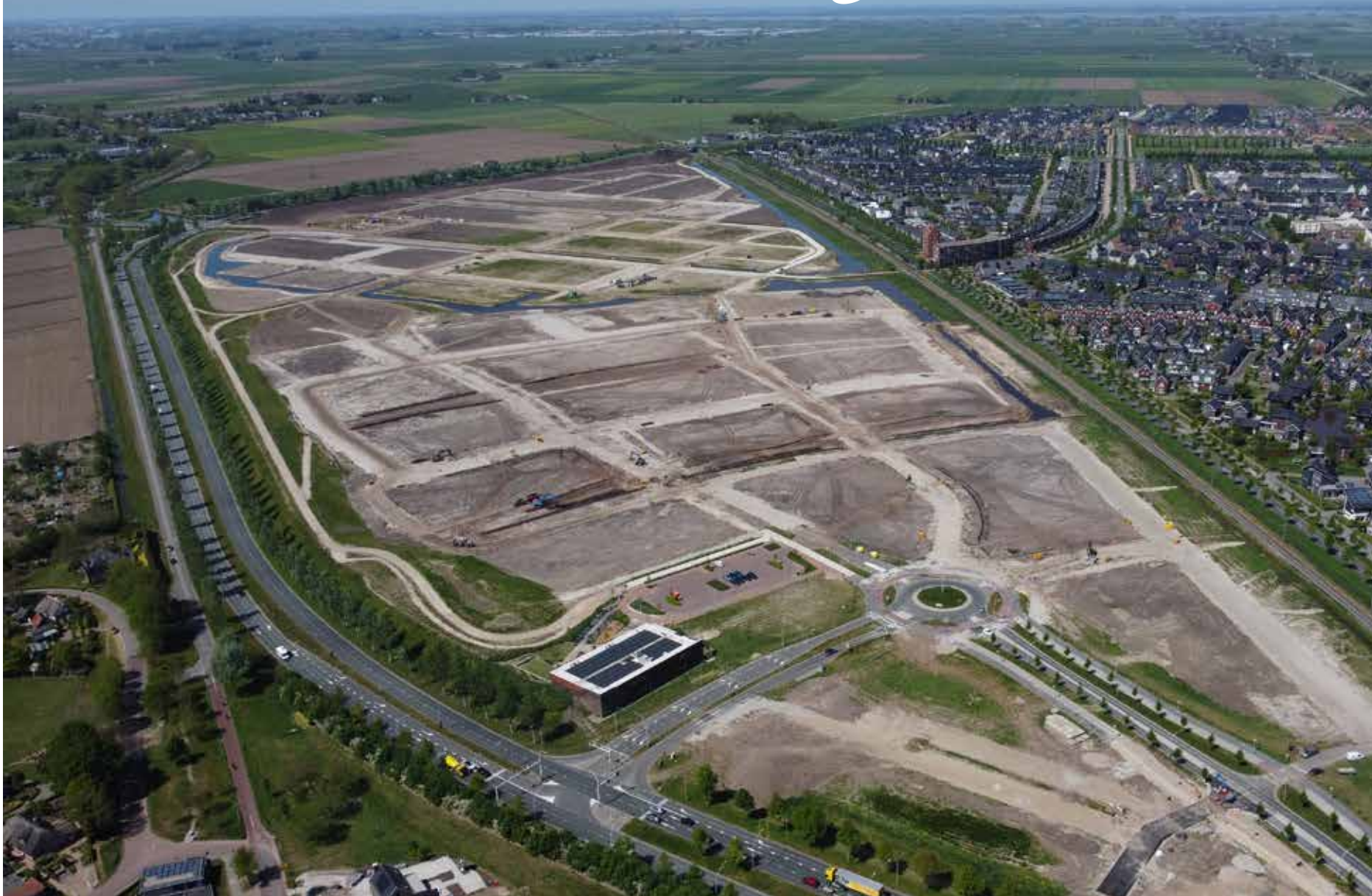
Het bouwrijp maken van De Tippe is in volle gang
