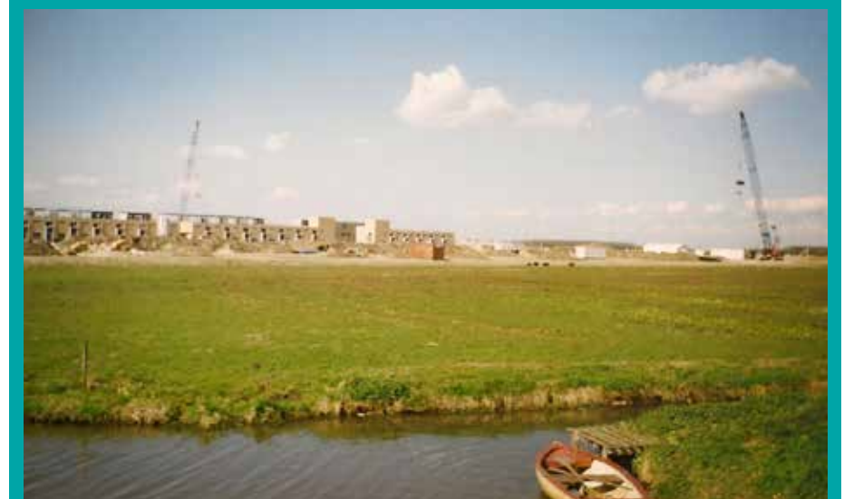
Beeld vanaf de Hasselterdijk (Rademakerszijl) op de eerste in aanbouw zijnde woningen (o.a. Tolgaardestraat)
